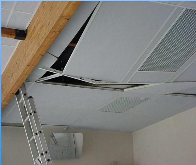
*Effondrement d'un faux plafond d'une piscine couverte communale, fixé par des tirants en acier inoxydable*
